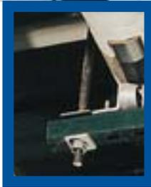
*Les roulettes sont vissées au profilé, permettant ainsi aux tuyaux de bouger plus librement.*
