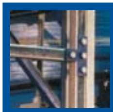
*Les raccords qui emboîtent l'échelle au cadrage en métal permettent un soutien ferme et solide, pour parer aux glissements éventuels des structures.*
